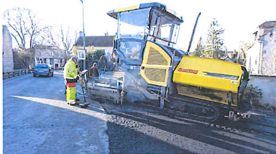
La réfection de la Venelle de Béneauville.
